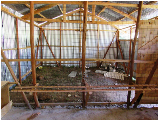
De kippenfarm in aanbouw
